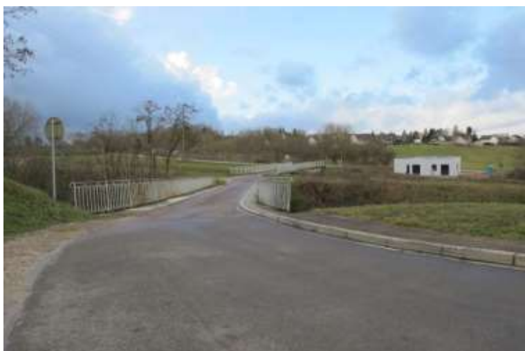
Le 2 ème pont avec le pôle santé
