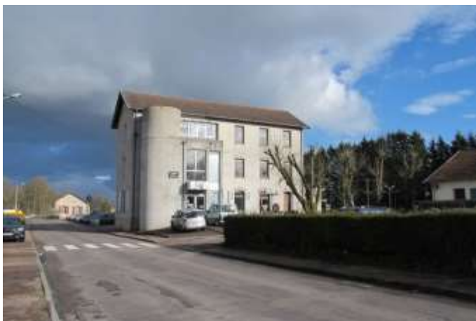
le bâtiment des associations
