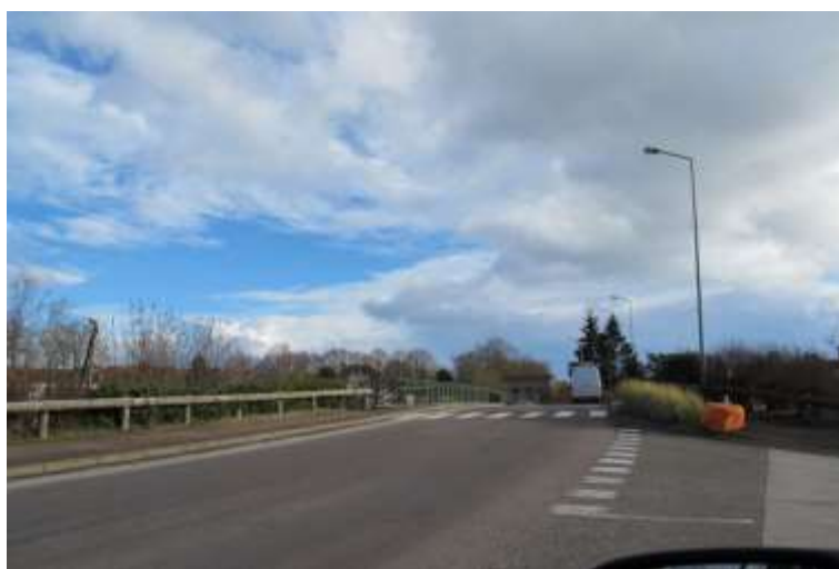
Le pont sur les voies ferrées reliant Is à Marcilly
